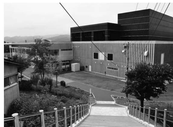
整備された階段から望む (虹のプラザ東面)
