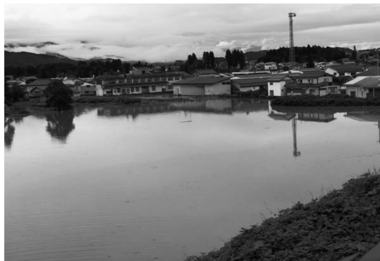
いざざわ 五十沢川からの越水による被害(今宿地区)
