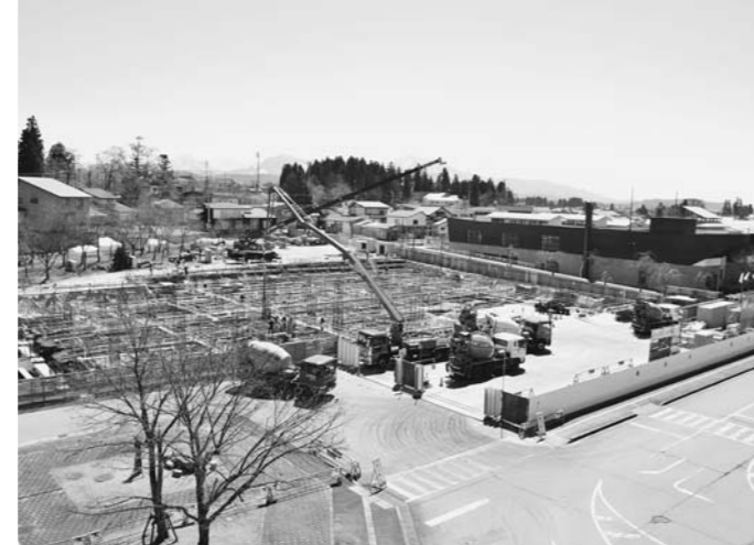
すすむ交流センター建設
