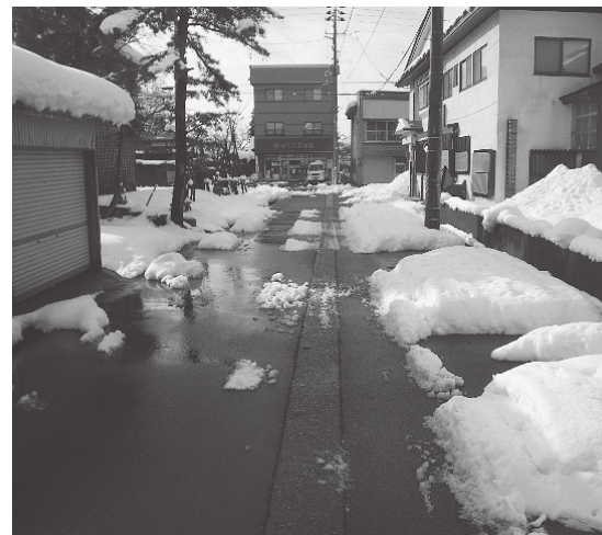
老朽化していく消雪道路（雪が消えずに残って道を狭くしている）
