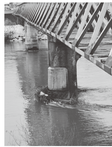
大橋の橋脚に引っかかったゴミ (12/19)
