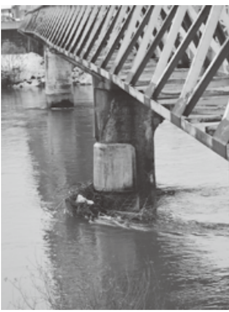
大橋の橋脚に引っかかったゴミ (12/19)
