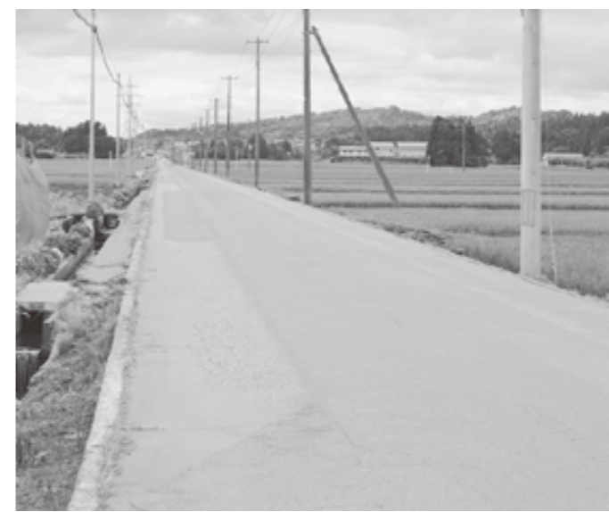
かまぼこ型に丸く、ひび割れも目立つ。人も車も走りにくい…。
