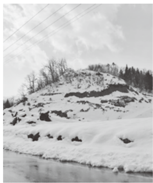
黒滝山の土砂流出現場 (12/19)
