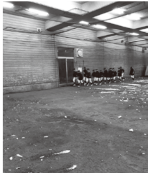
冬期間は雪でほこり対策のピロティ
