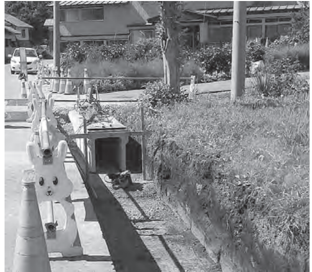
完成が遅れている流雪溝工事（鷹巣地区）
