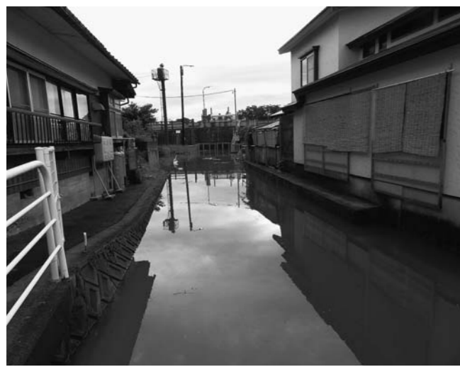
最上川増水時は内水が溢れる金川 (横山下宿地内)
