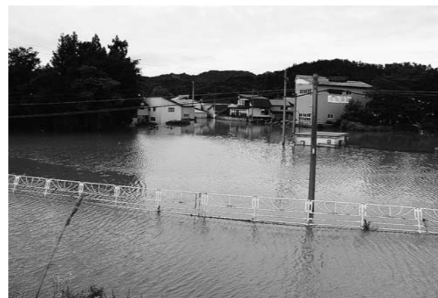
被害が大きかった豊田地区
