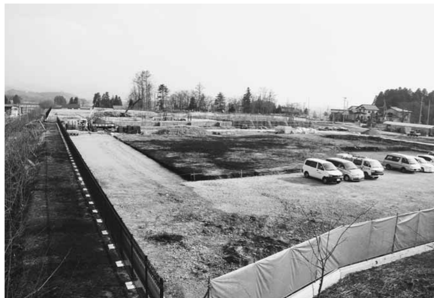
建設がすすむ統合中学校
