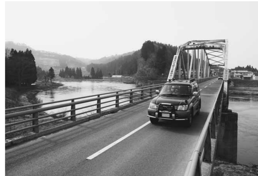
早急な架け替えが望まれる亀井田橋
