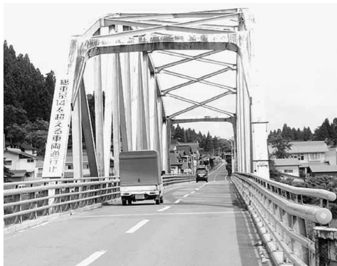
架け替えを待つ亀井田橋
