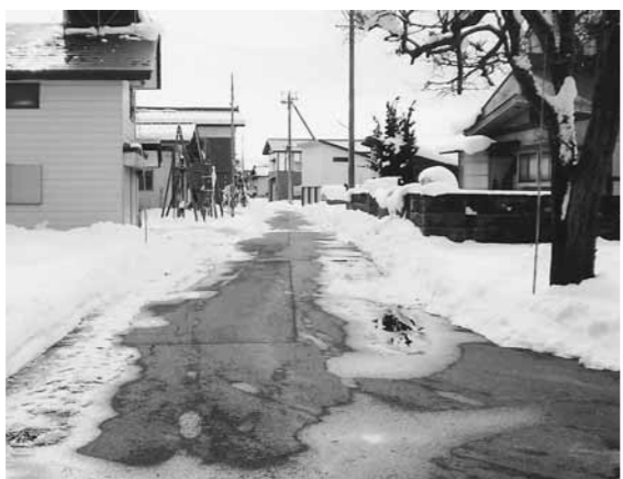
待てない流雪溝整備(小菅地内)
