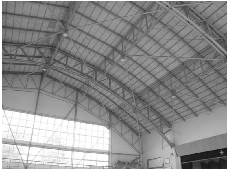
一中体育館解体でた有価物は有益に処理されたのか
