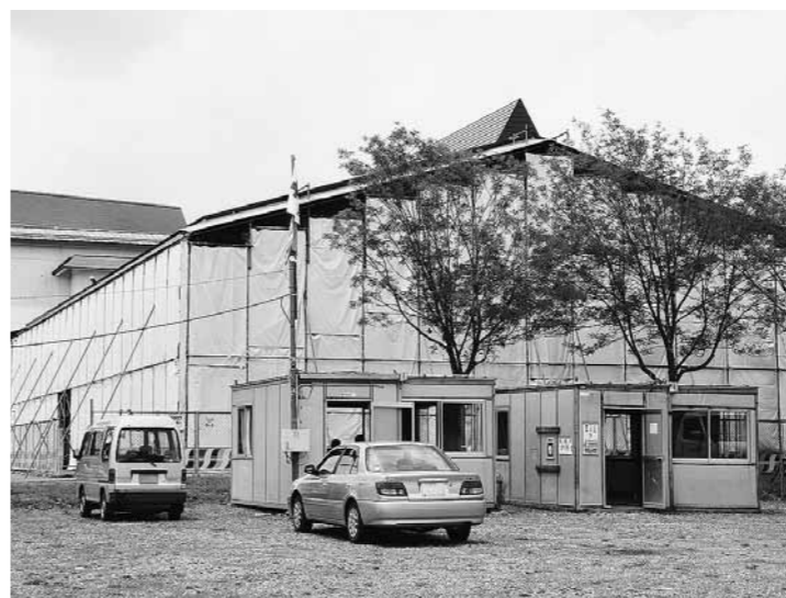
工事中の北小体育館
