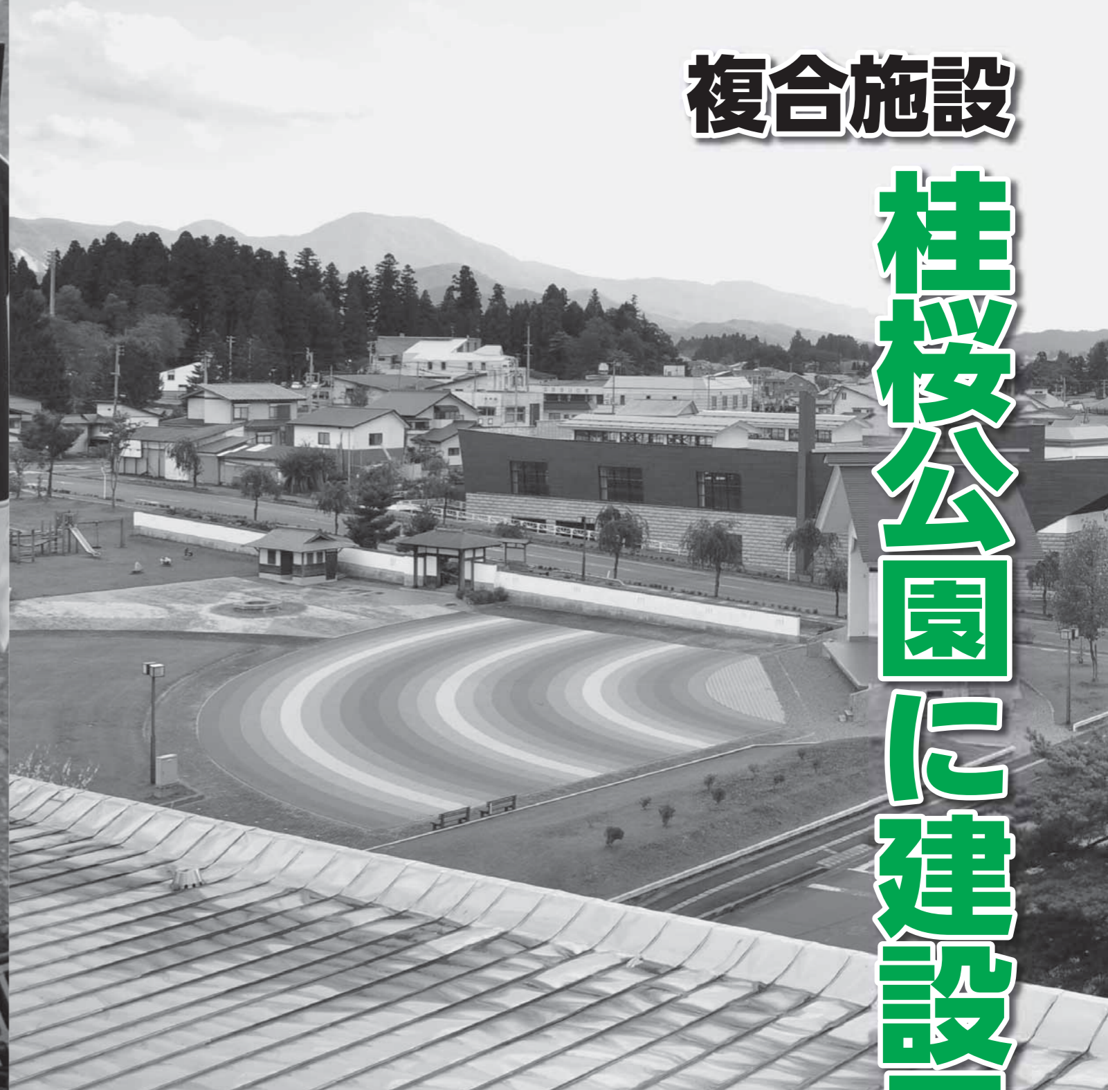
1日も早い完成を(庁舎屋上から)
