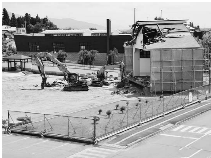
解体始まる桂桜公園
