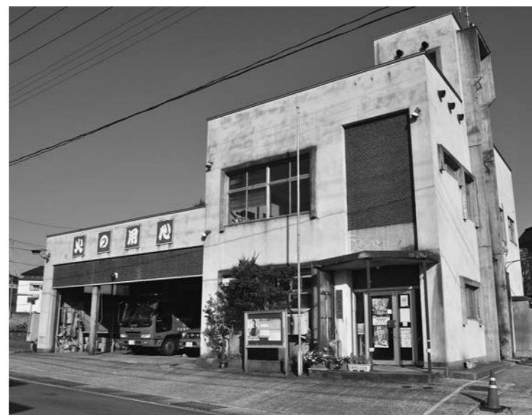
建て替えが急がれる消防分署
