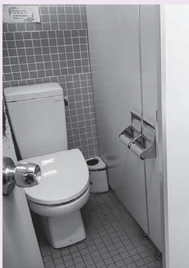
狭く窮屈なトイレ（大石田駅）
