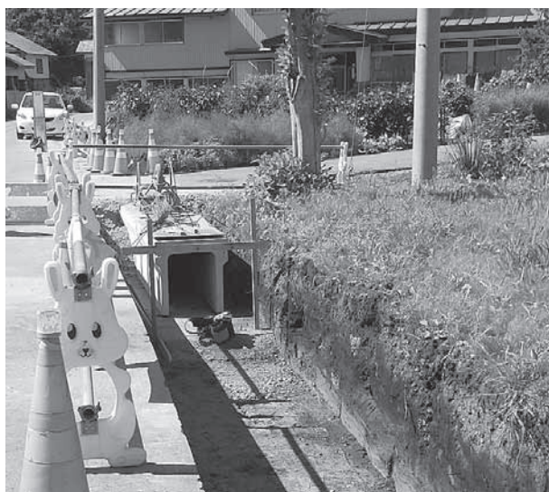
完成が遅れている流雪溝工事(鷹巣地区)
