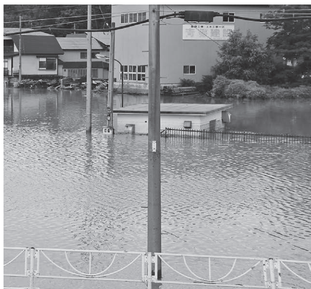
7月豪雨で水没した処理場（豊田地区）
