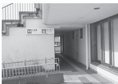
改修される大石田駅トイレ
