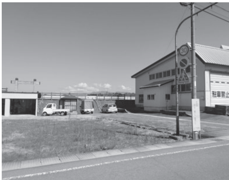
引き堤予定の横山上宿地内
