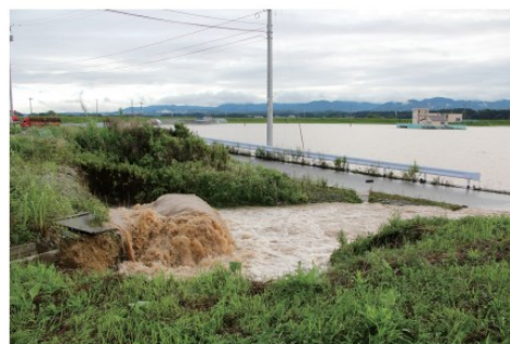
豊田地区：上水道の水源場が浸水
