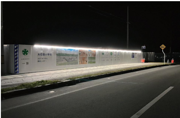
▲ 現場西側仮囲いに照明設置
