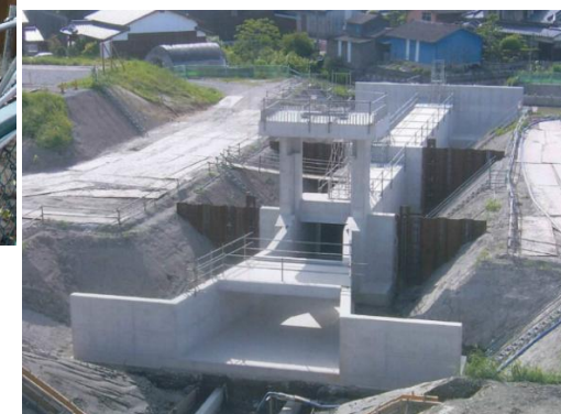
「樋門・樋管本体」イメージ ※他工事完成写真参考
