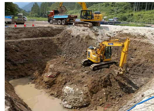
②躯体施工箇所の掘削 ※イメージ
