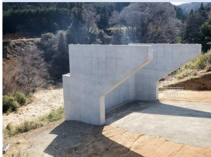
[②施工例] 橋台工 (R8.8月~) ※躯体本体仕上がりイメージ (他工事完成参考写真)
