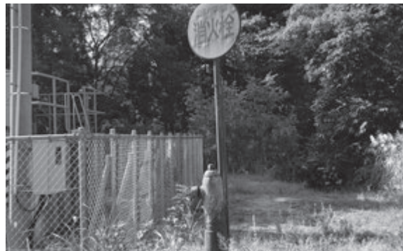
消火栓226か所のうち、修繕件数は、年間3~5か所と少ない
