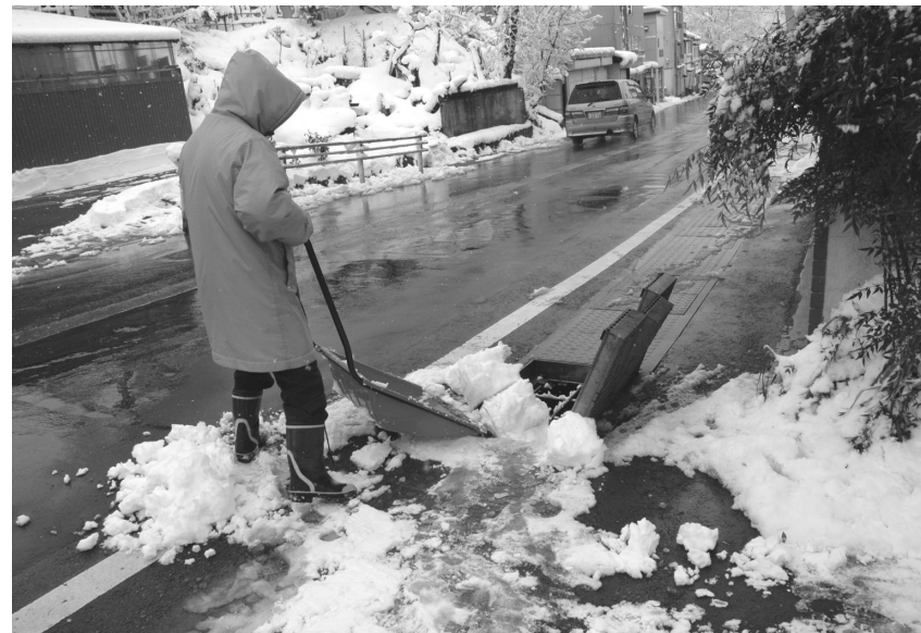
整備が進む流雪溝
