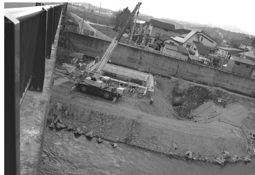
横山地区流雪溝の工事始まる
