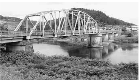
架替えられる亀井田橋
