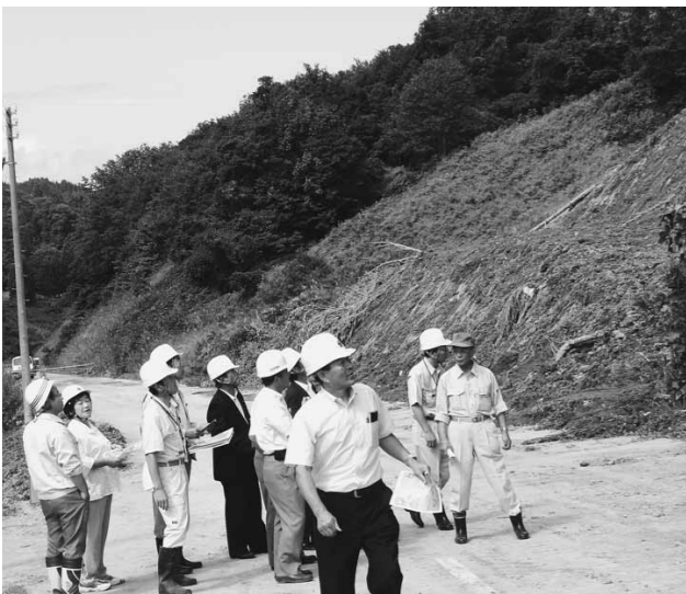
土砂崩れ現場視察から
