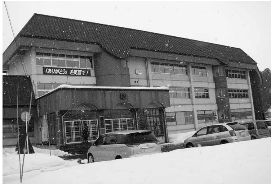
横山地区のシンボル横山小学校
