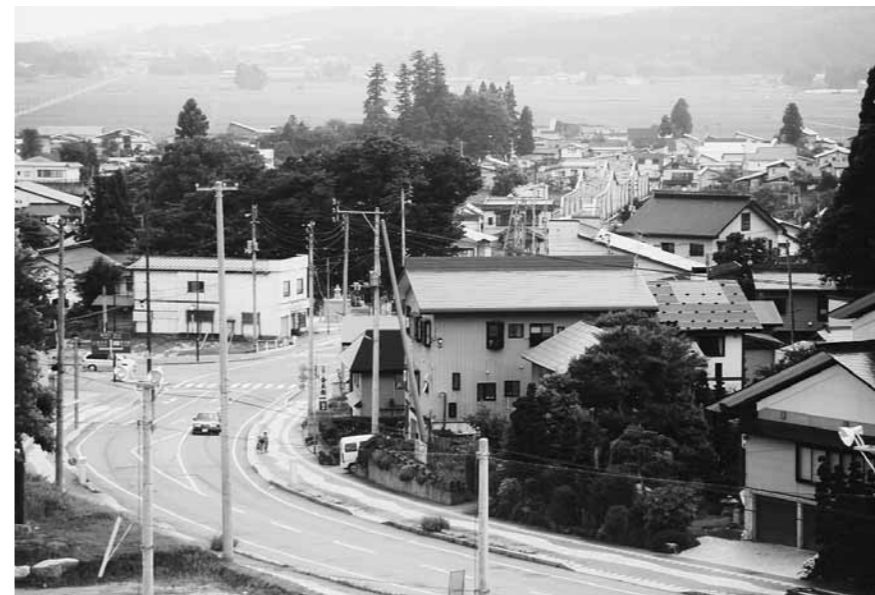
どう変わる大石田町の未来(大石田中屋上より)
