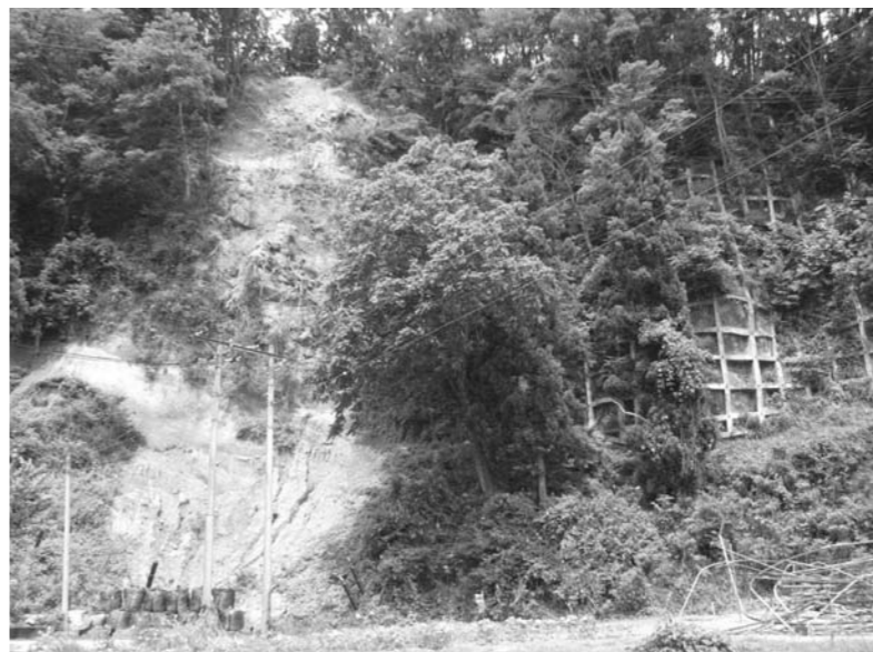
今回の地震で発生した地すべり（川前地区）
