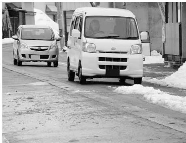
施設改善による延命が求められる消雪道路
