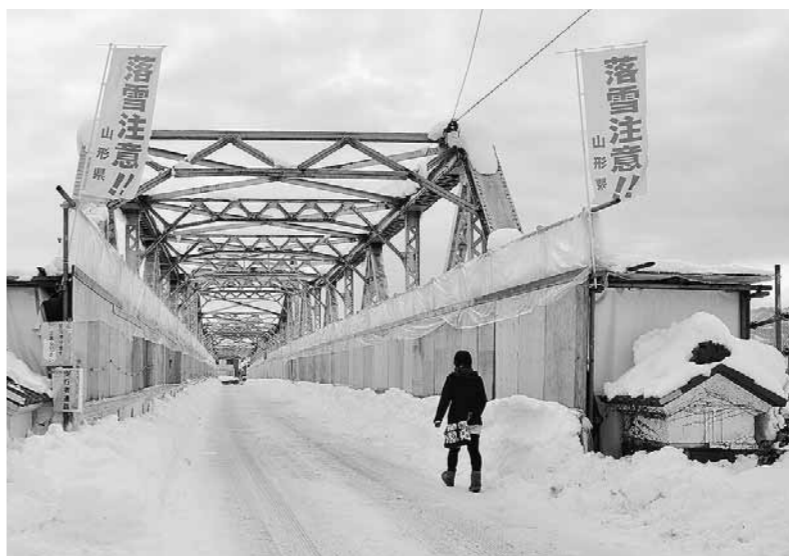
補修工事中の大橋
