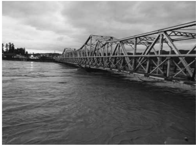
増水で通行止めになった大橋
