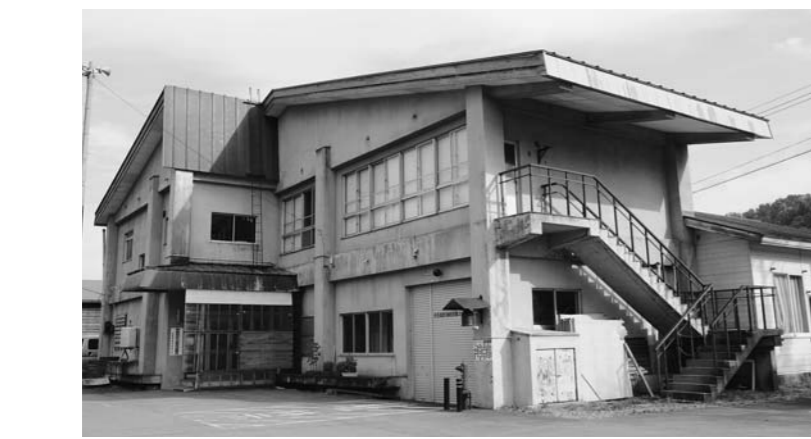
水洗化工事予定の駒籠公民館
