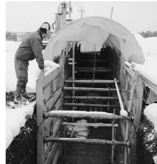
雪の中の流雪溝工事
