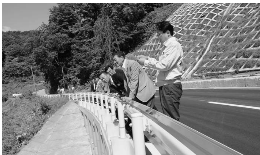
開通した白鷺線(平成27年6月10日)
